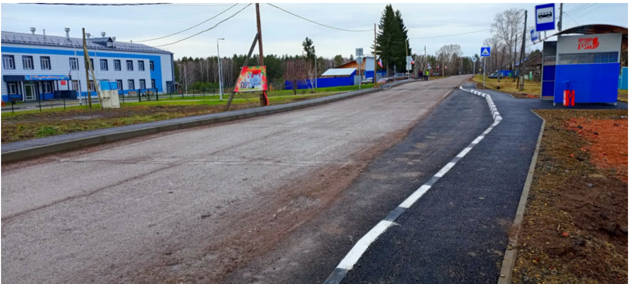
ФОТО №7 Пути движения к объекту (от остановки транспорта)
